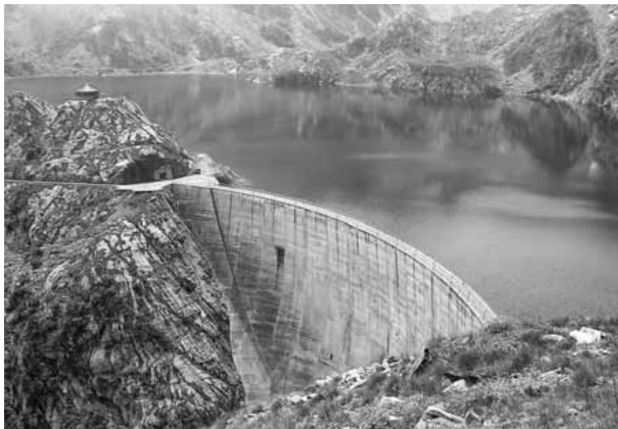
Figura 7 – Con una potenza netta di 1.065 MW, la centrale idroelettrica "Luigi Einaudi" di Entracque (Cuneo) è la più grande centrale idroelettrica italiana. Particolare della diga ad arco a doppia curvatura.
