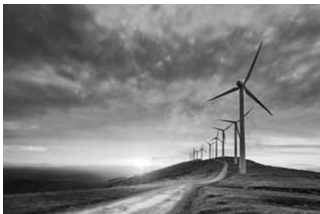
Figura 1 – Impianto per la produzione di elettricità da fonte eolica.
