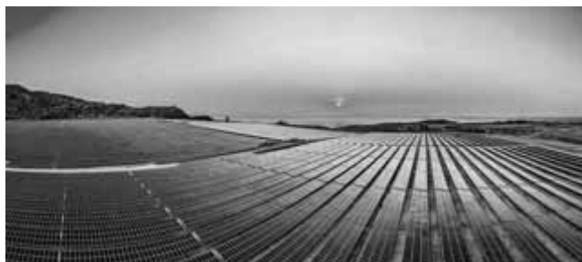
Figura 2 – Impianto per la produzione di elettricità da fonte fotovoltaica.
